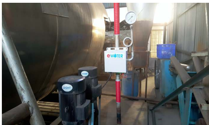
Lò hơi 5 tấn lắp máy xử lý cáu cặn Ewater EB100
