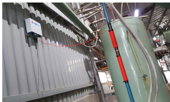
Lò hơi 1,5 tấn lắp máy xử lý cáu cặn Ewater EB50
