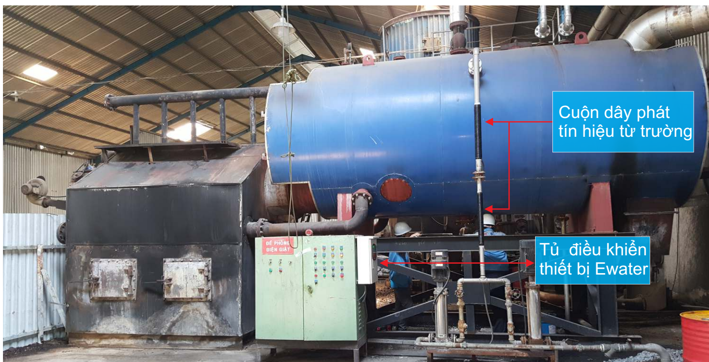
Lò hơi 10 tấn lắp máy xử lý cáu cặn Ewater EB200
