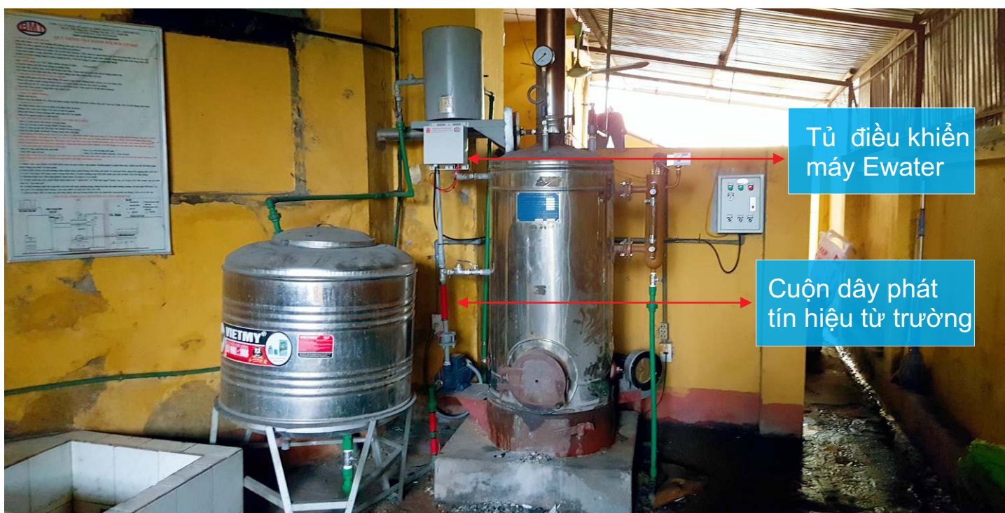
Bếp lò tại một doanh trại có lắp thiết bị xử lý cáu cặn do công ty Ewater sản xuất
