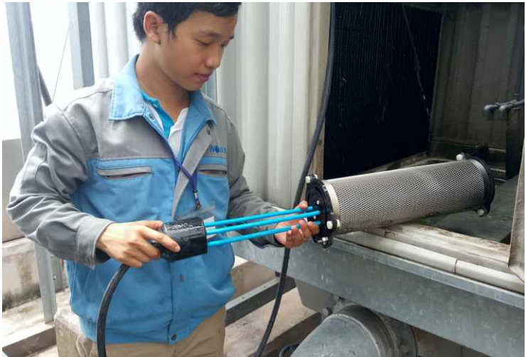
Collector tại thời điểm lắp vào trong tháp
