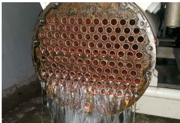
Condenser sạch hơn sau khi lắp Ewater
